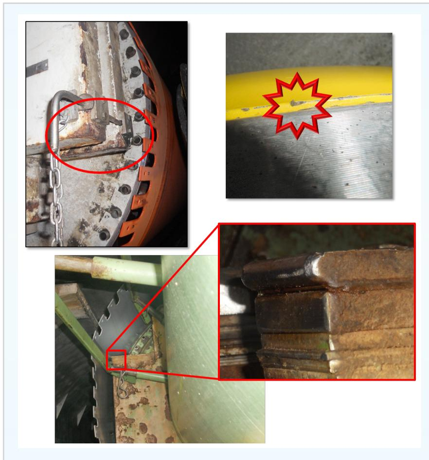
Figura 6: Exemplos de superfícies pontiagudas/cortantes expostas durante a instalação da manta.
